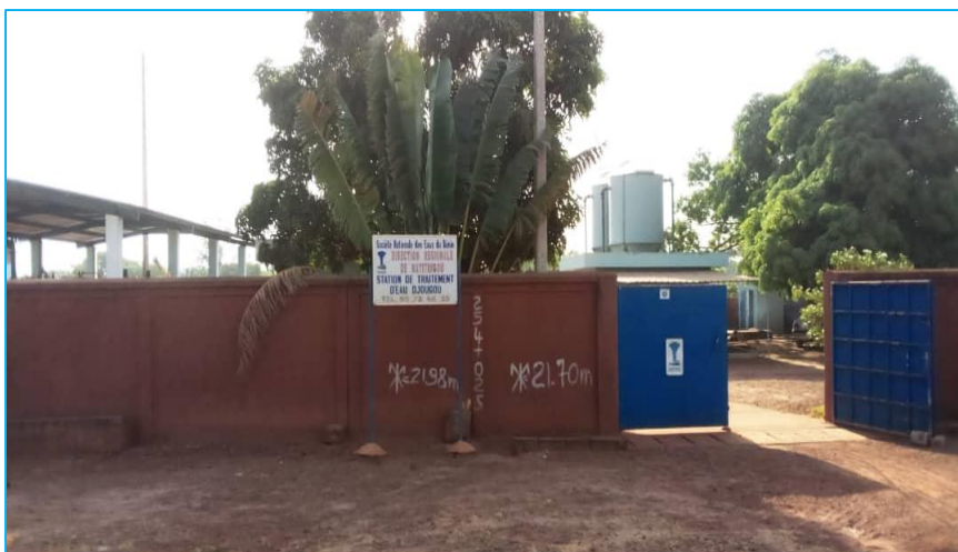
Photo 11 : Vue partielle de la Station de traitement d'eau de Djougou
