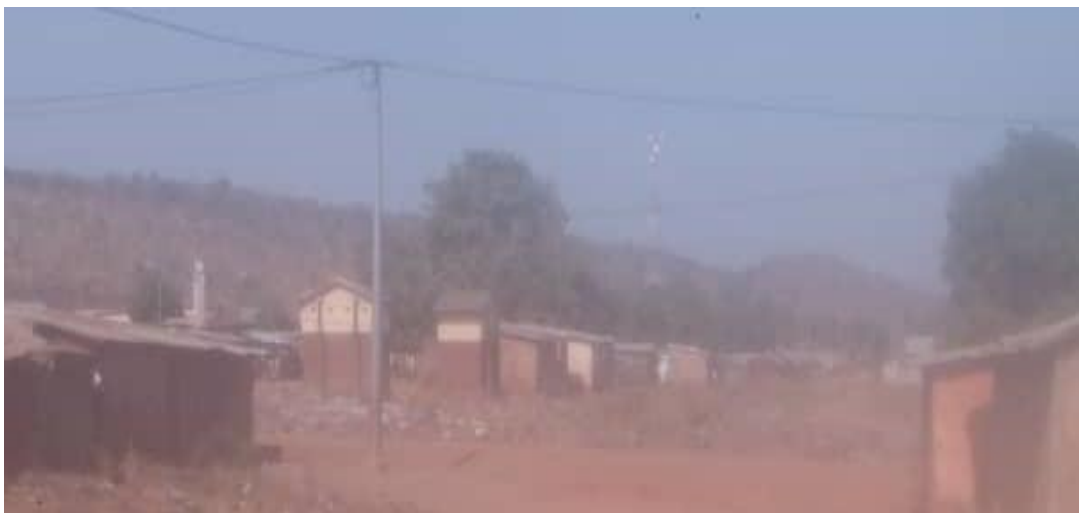
Photo 18 : Vue partielle du réseau électrique à Guilmaro
