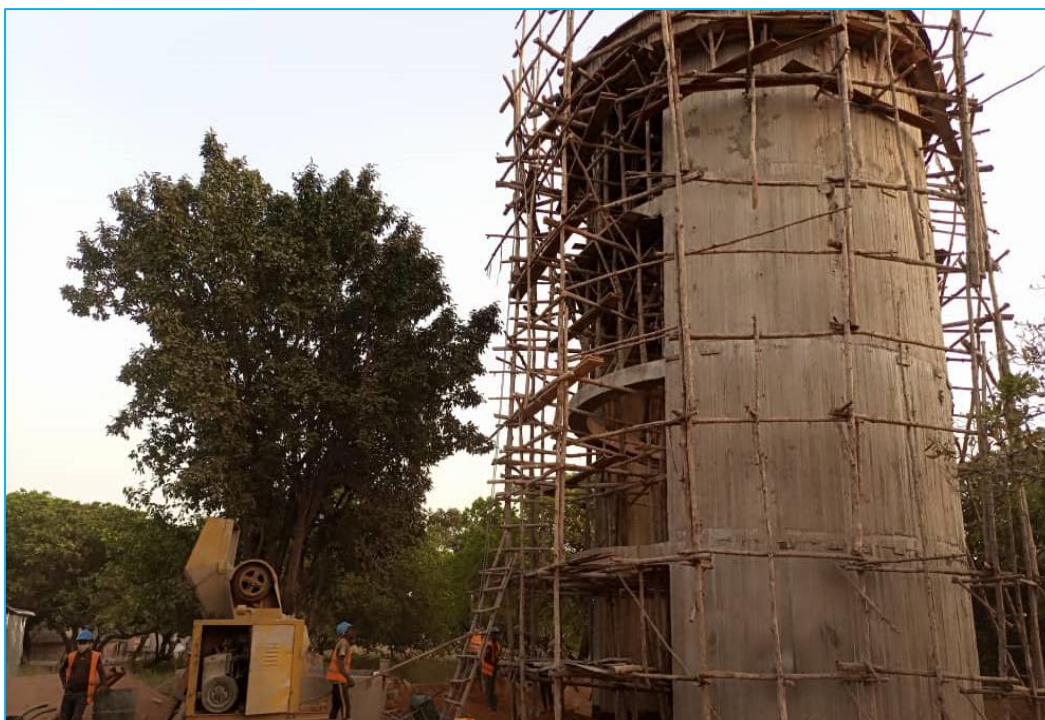
Photo 3 : Vue partielle du château d'eau en construction à N'Dali
