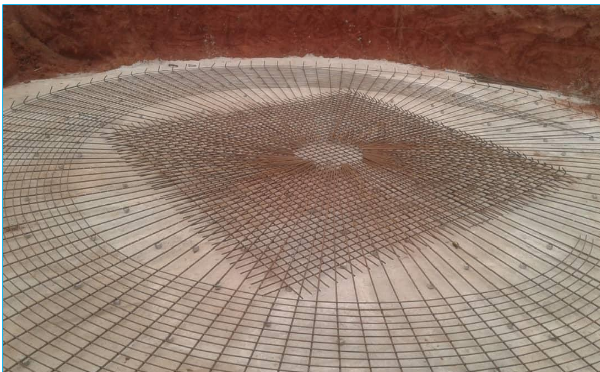
Photo 7 : Vue à l'interne du chantier de Agbangnizoun (site de Kpota)
