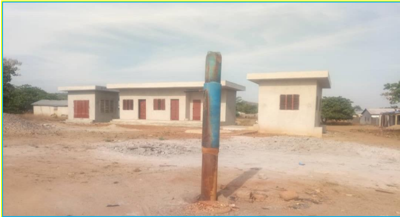
Photo 1 : Vue partielle du forage de Tchimbéri (arrondissement d'Alédjo, Commune de Bassila)
