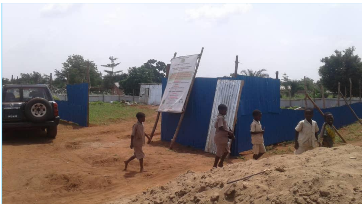
Photo 6 : Vue de l'extérieur du chantier d'Agbangnizoun (Site de Kpota)
