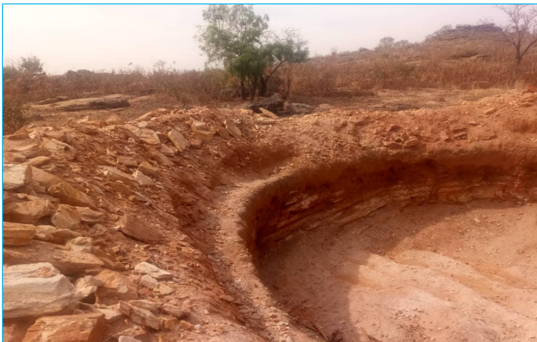
Photo 2 : Vue partielle du site devant abriter le château d'eau de Tchimbéri
