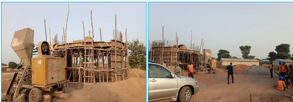
Photo 5 : Le chantier de Ganshon-Daroupkara dans la commune de Nikki
