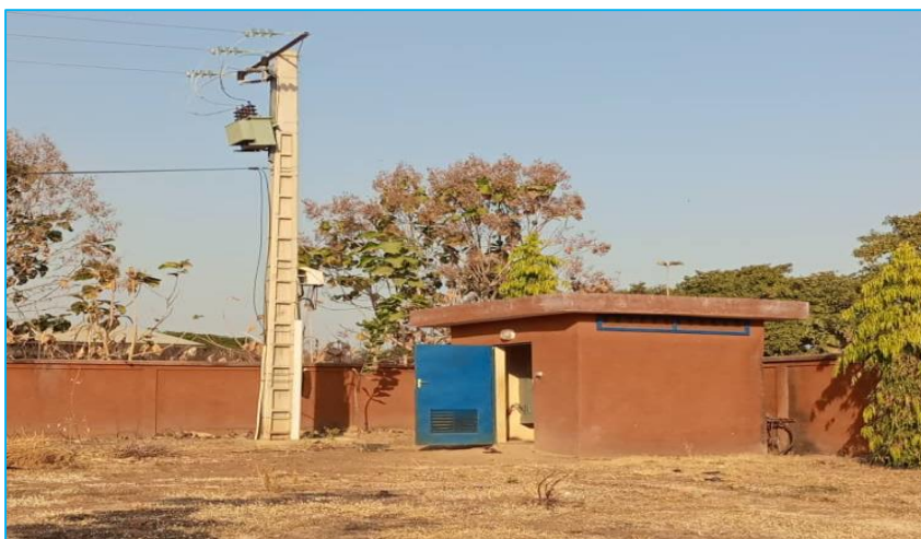
Photo 12 : Vue partielle (A) du Site de forage de Bariénou
