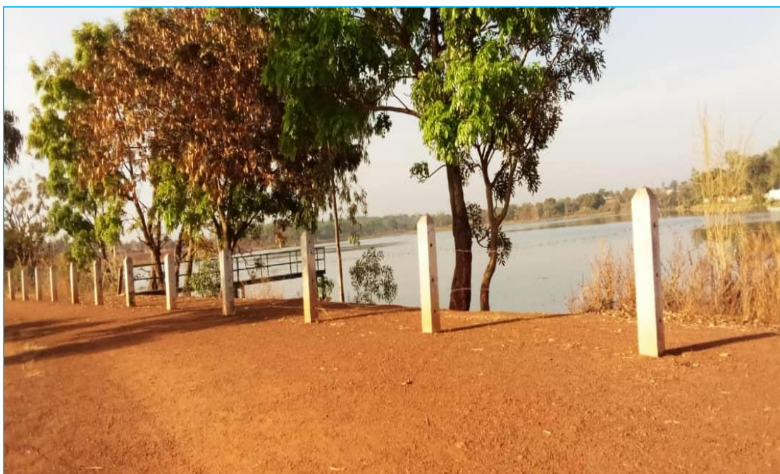
Photo 10 : Vue partielle du barrage réhabilité à Djougou
